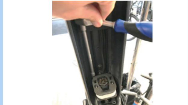
54. ábra: Belső hatlapfejű csavarok eltávolítása
